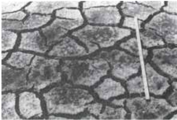
شکل ۱۹-۴- کف استخر پس از خشک کردن
